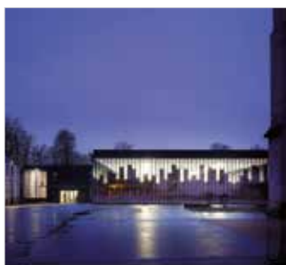
GYMNASSE ET ESPLANADE DE L'HÔTEL DE VILLE Orléans / LAN Local Architecture Network
